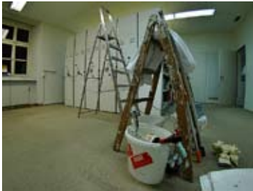
Sanierungsbedürftig: Vom 30jährigen Teppich im Sekretariat (oben) bis zum Fensterladen an der Dachlukarne (unten rechts).
